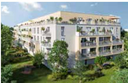
Résidence Les Balcons de Chilly - Chilly-Mazarin (91) - Altarea Cogedim
